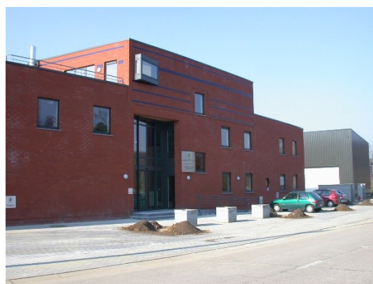
Service Travaux Avenue de Veszprem, 5 Avenue Georges Lemaitre
